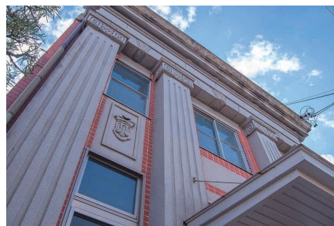
清水銀行 1925年に建てられたイオニア式の柱が特徴のコンクリート造の建築物。国の登録有形文化財です
